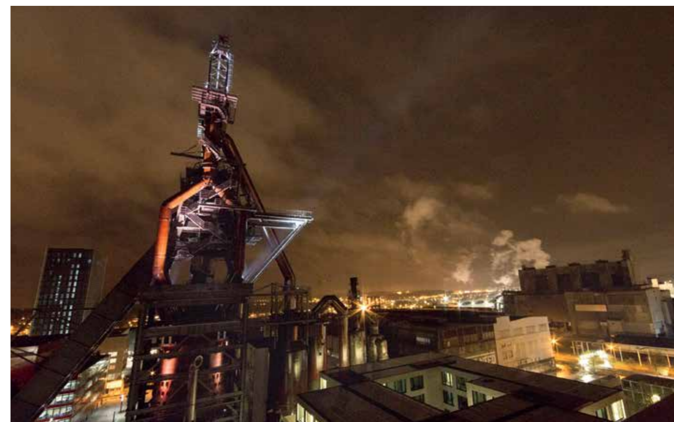
Vue nocturne du haut de la plateforme du gueulard du haut fourneau A
